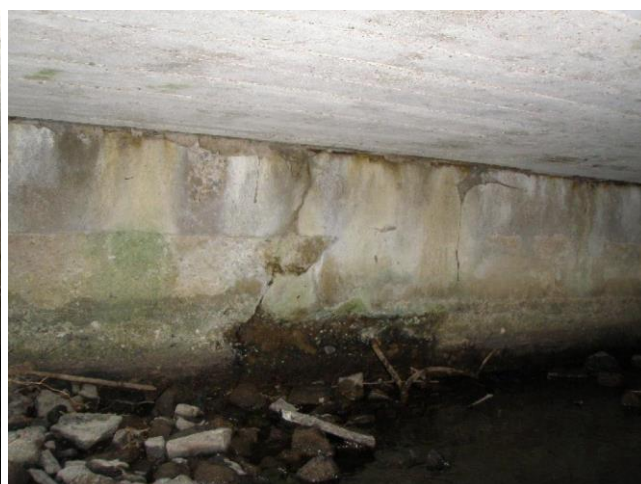
hloubkově poškozený beton u paty opěry na konci mostu
