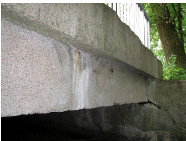
vápenité výluhy na boku NK vpravo
