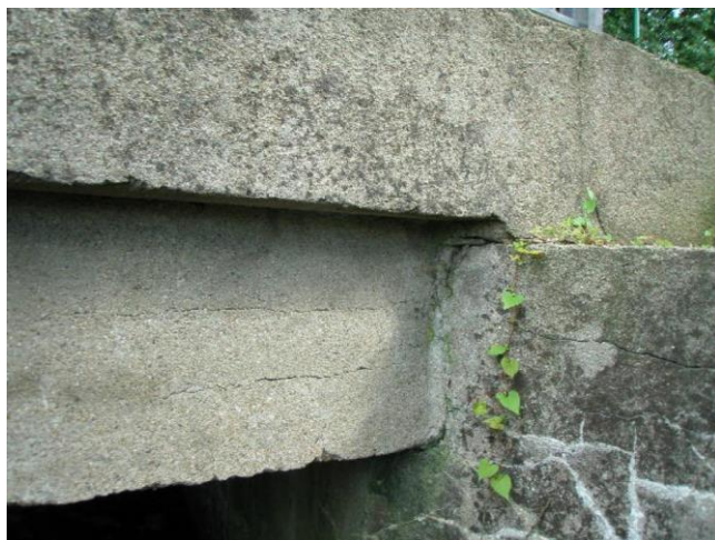
podélné trhliny na boku NK vlevo
