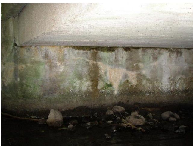
trhlina na čele opěry na zač.mostu s vápenitými výluhy
