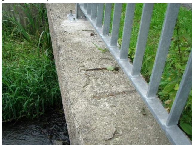
obnažená a zkorodovaná výztuž na horní ploše římsy vlevo
