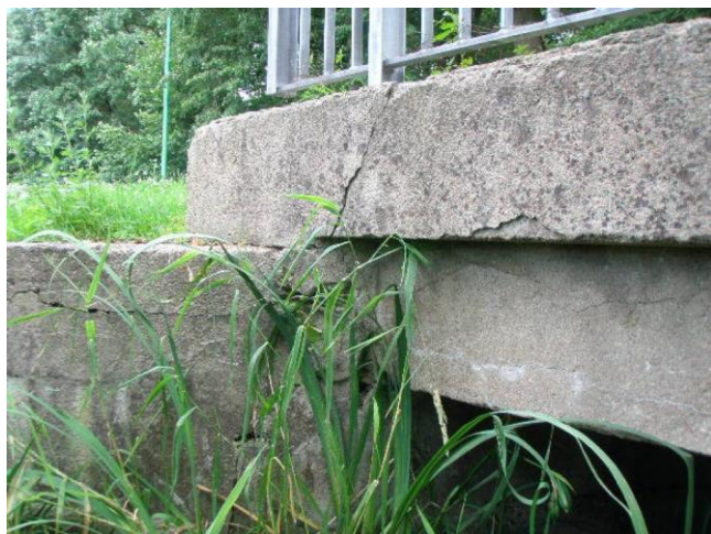
trhlina v římse vlevo
