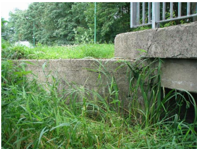
vodorovná trhlina v křídle na konci mostu vlevo
