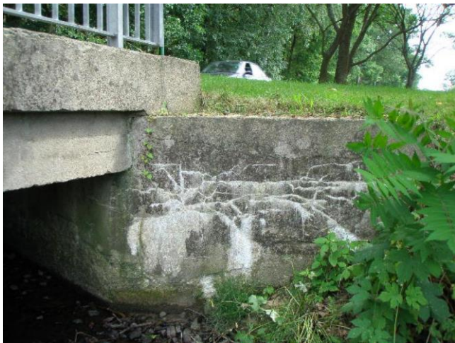
popraskané a poteklé křídlo na začátku mostu vlevo (proti směru staničení)
