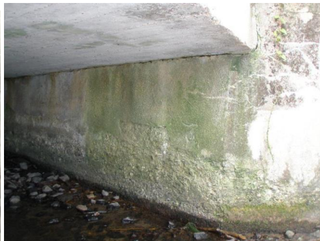
hloubkově poškozený (vymletý) beton na čele opěry na zač.mostu
